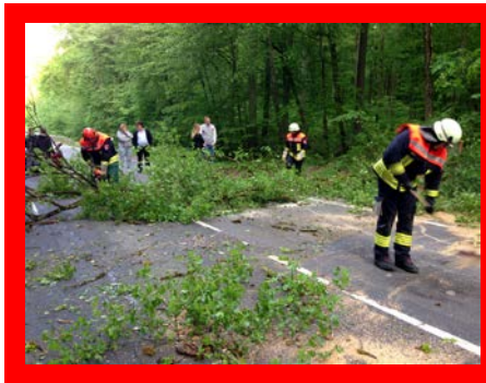
Straße frei- räumen nach Sturmschaden
